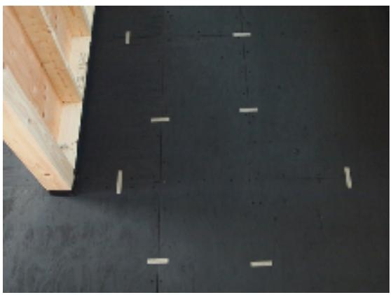
また同じく主寝室と子供部屋の壁面には、高周波電磁波シールドクロス(下地壁紙)を張り、クロスによって形成された一面によって外部からの高周波電磁波をカットしています。このクロスは低周波電磁波に対するシールド機能も兼ね備えていますので、キャッチした低周波電界を同様にアースによって大地に流して処理しています。クロスは継ぎ目での隣り合うクロスに 10 cm程度重ねて貼り、その各継ぎ目にはアーステープを数カ所にわたって貼りクロスによる電界面に裂け目がないように注意します。
