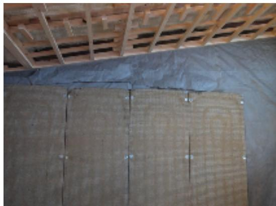
シールドペンキおよびシールドクロスの施工の後には、塗られたペンキ面に裂け目がないか、貼られたクロスに穴や切れ目がないか、つまり一枚の連続する電界になっているかをチェックします。
